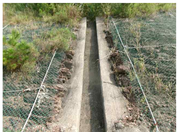
숯크리트, 점검계단 전경
