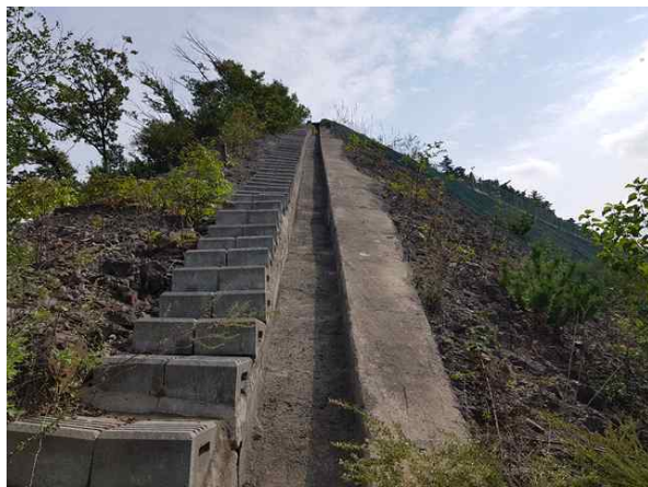
산마루측구, 점검계단 전경
